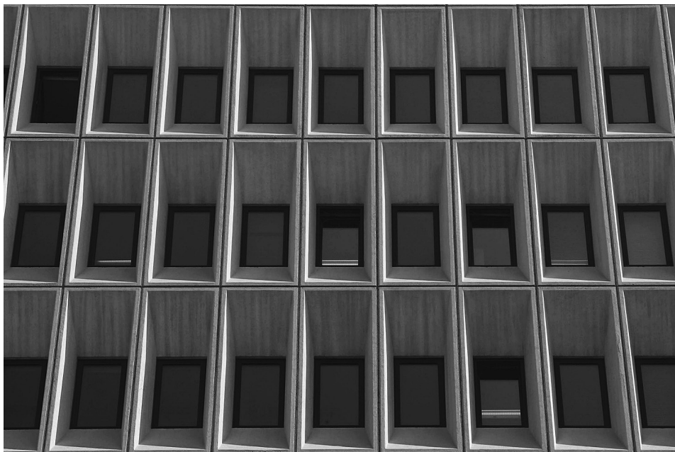
FIG. 9. E. Caballero y J. L. Dorronsoro, Delegación de Hacienda en Málaga, 1975-1979. Detalle de los prefabricados, 2008.
