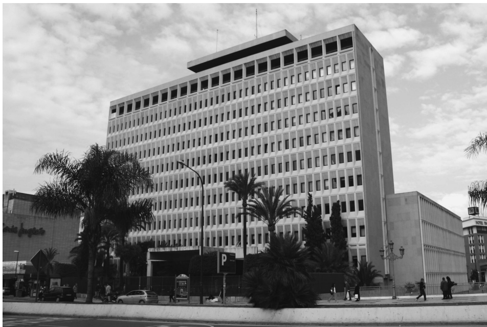
FIG. 8. E. Caballero y J. L. Dorronsoro, Delegación de Hacienda en Málaga, 1975-1979. Fachada principal, 2008.
